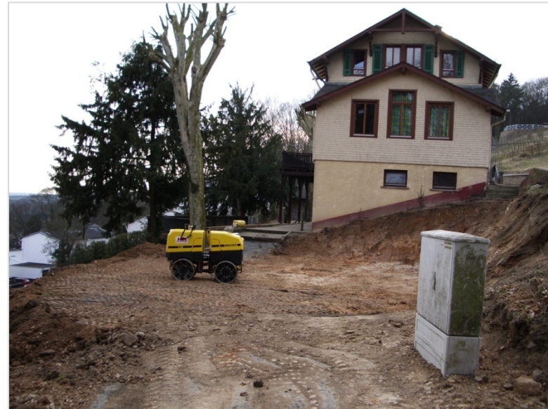
Bauplatz des Vereinsheims im Winter 2004/2005
