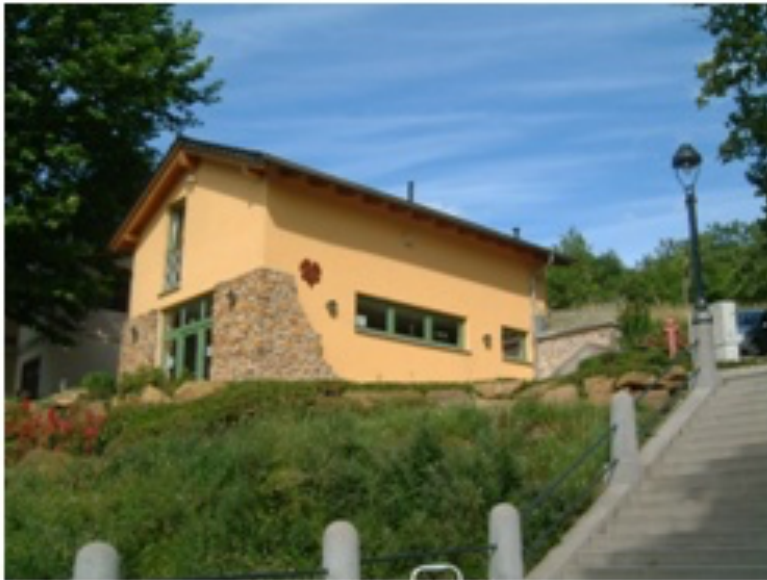
Das Vereinsheim nach der Fertigstellung 2005
