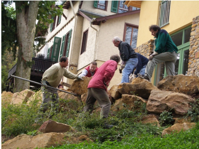
Schwerstarbeit bei den Außenanlagen
